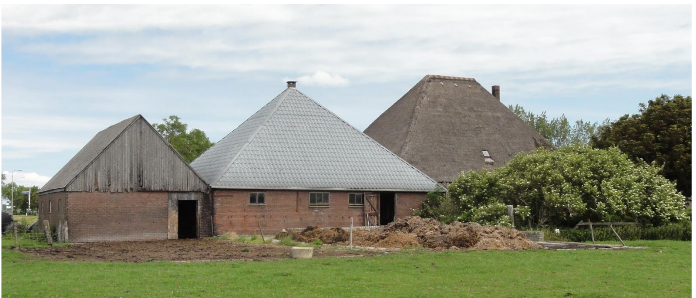
Gevens aan de zuidzijde
