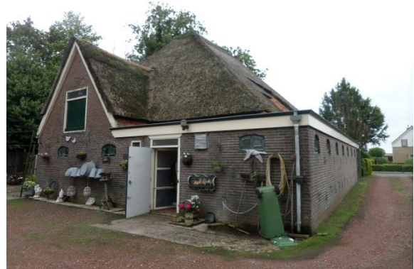
Platte aanbouw aan linker zij- en achtergevel
