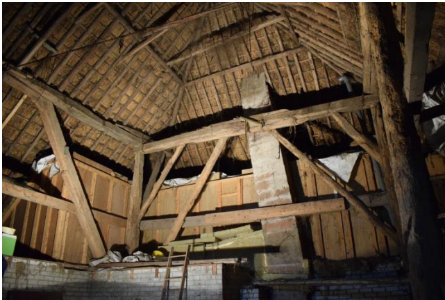
Aanzicht kap met vierkant met extra schoren
