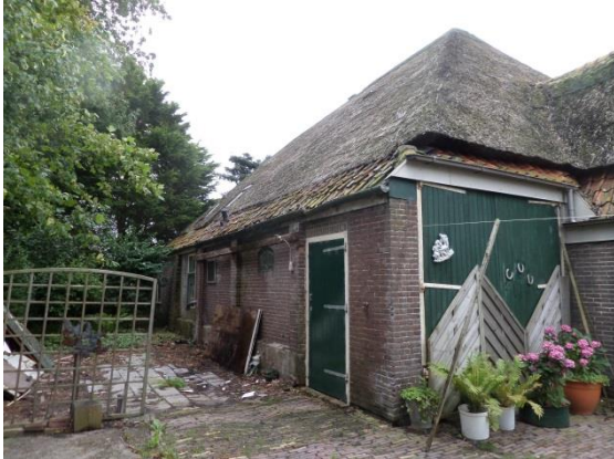
Achtergevel en rechter zijgevel
