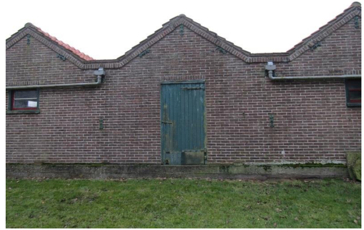
Achterkant met de deur naar de sloot
