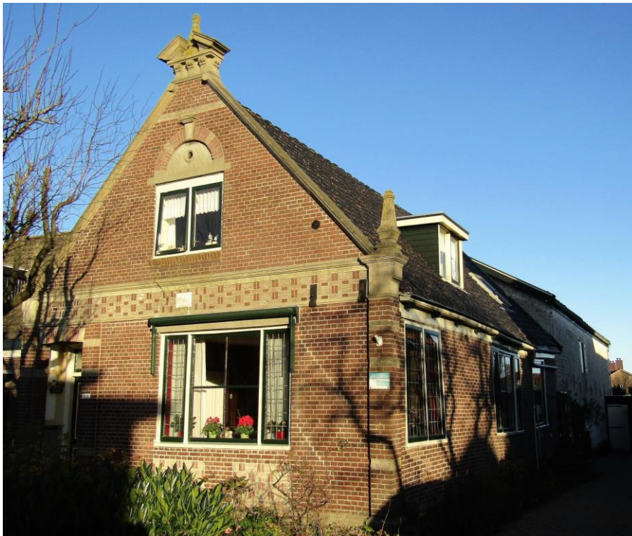
Het fraaie huis met koolschuur aan de Dorpsstraat.
